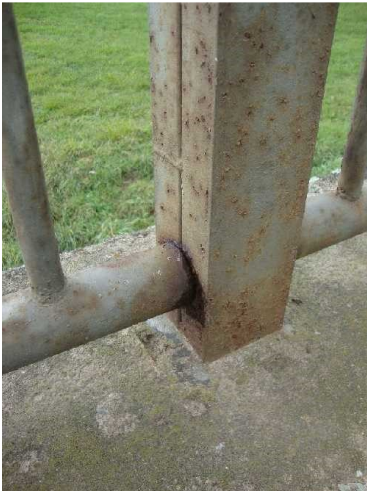
Zábradlí – detail připojení dolního madla.
