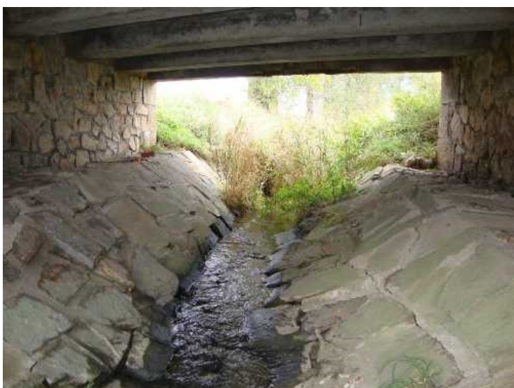
Lokální poruchy v odláždění koryta pod mostem.
