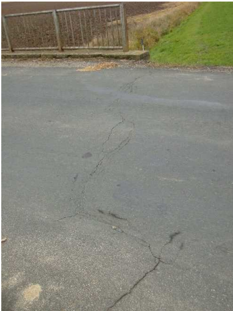
Příčná trhлина v krytu vozovky u O2.
