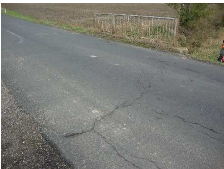
Příčná trhлина v krytu vozovky u O1.
