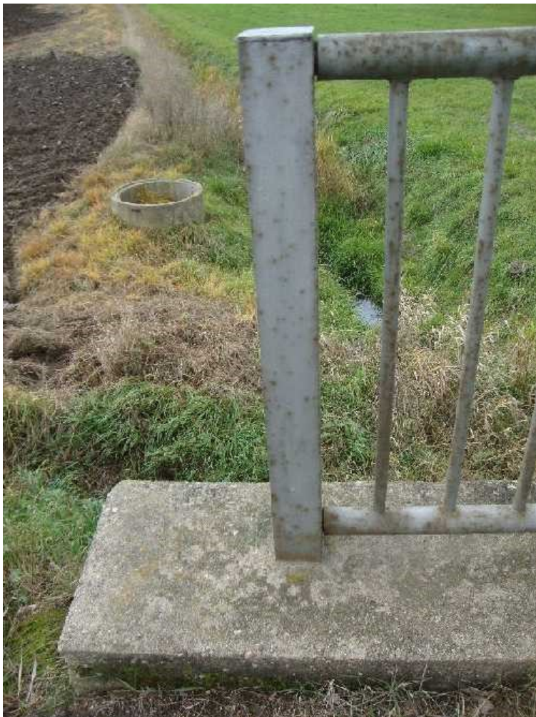
Pravá římsa – koncový sloupek zábradlí (O1).
