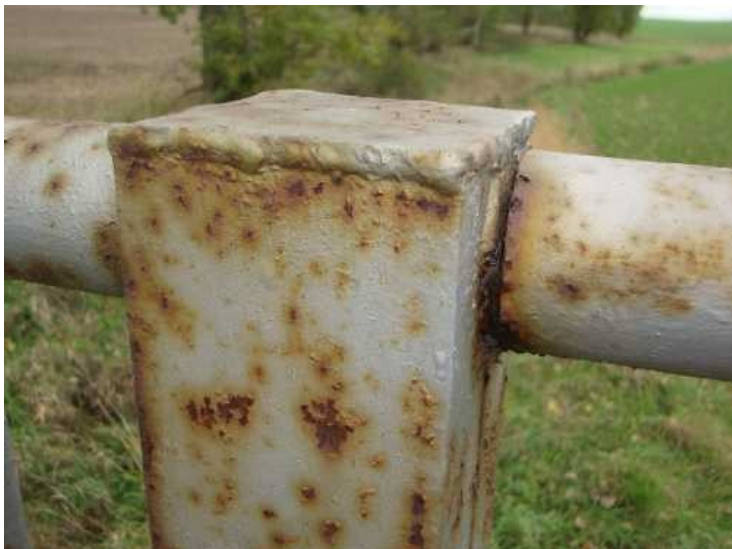
Detail koroze zábradlí.
