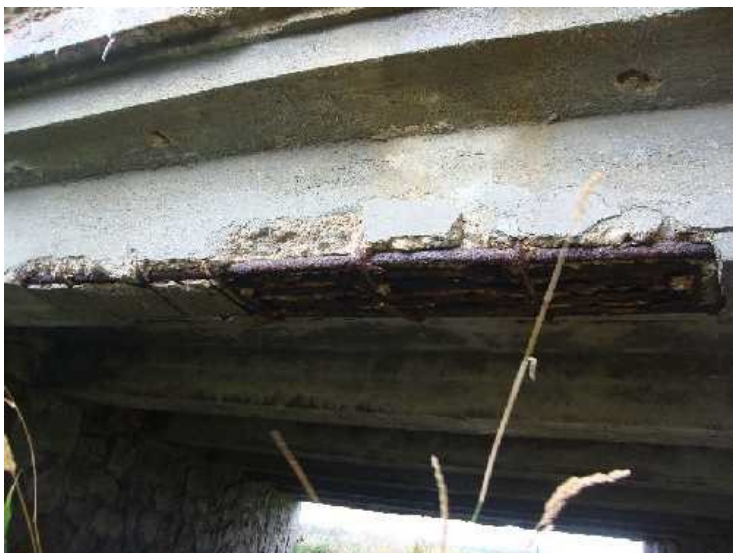
Obnažená výztuž krajního trámu č.7 - detail.
